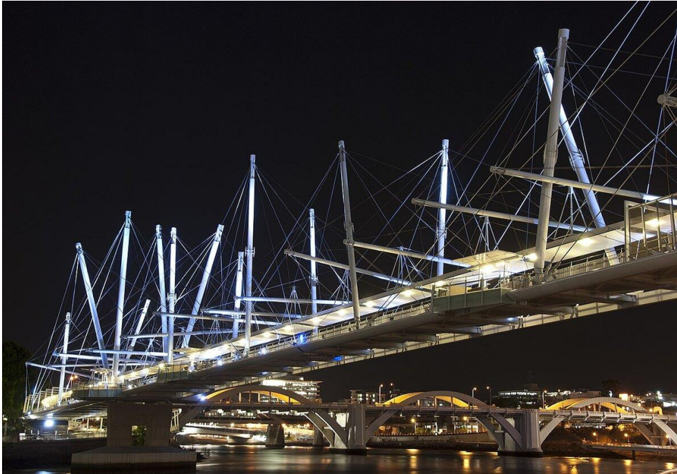
Рисунок 11 – Kurilpa Bridge – крупнейший мост в мире, построенный на принципе тенсегрители, Брисбен (Австралия)
