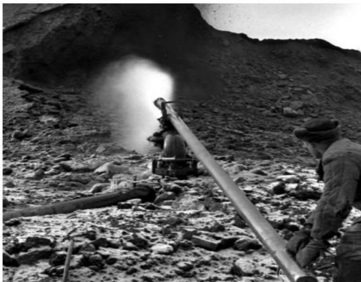
Рис. 2. Гидравлический способ удаления покровных отложений на разрезе Бачатский
