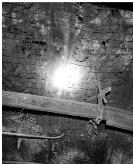
Рис. 2. Фото кровли имеющее незначительные деформации
