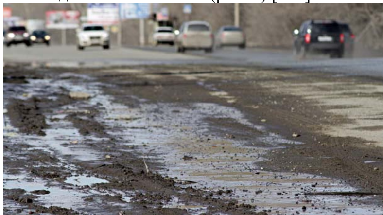
Рис. 1. Состояние участка дорожного полотна и обочины в весенний период, г. Челябинск
