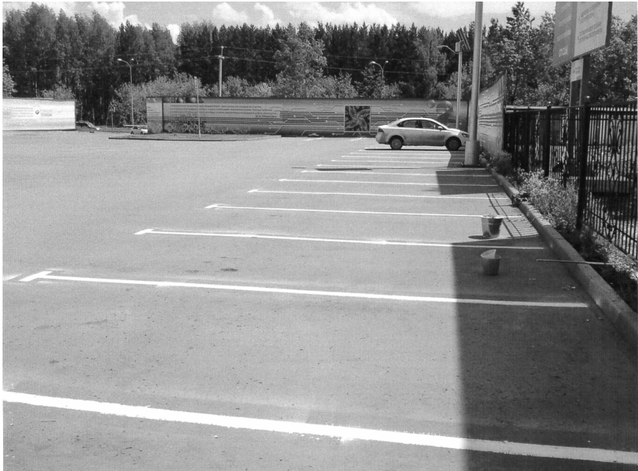
Рис. 1. Разметка автомобильной стоянки в Кузбасском технопарке силикатной краской
