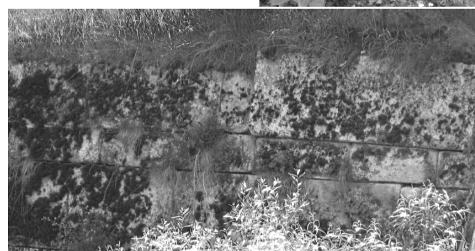
Бот это стеночка!!! Она идёт под чётко выдержаным уклоном. Из огромных гранитных блоков. Идеально ровная. Стыки между камнями очень плотные. Лезвие нельзя просунуть.
